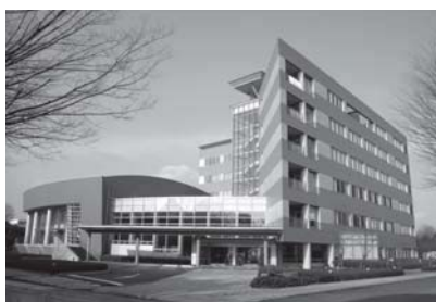
学院 養成・研修棟の外観
