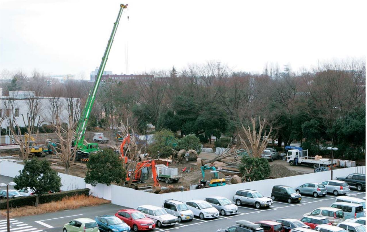
病院・本館等建て替え工事進行中 (写真は駐車場建設予定地)
