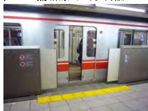
ホーム柵(東京メトロ丸ノ内線)
