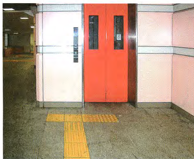
図2-32 エレベーターへの誘導例
