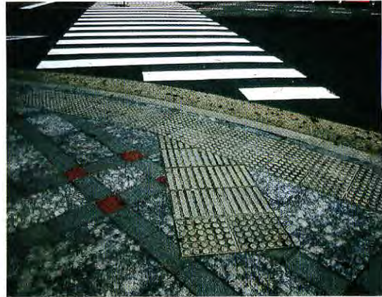
図 2-5 路面とのコントラストが低く、視覚的に活用が困難な例
