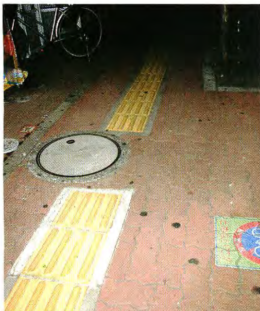
図2-2 マンホール部分のブロックを抜いた例
