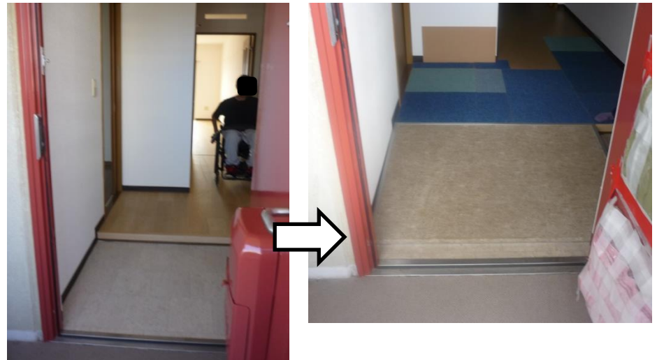
スロープの設置
