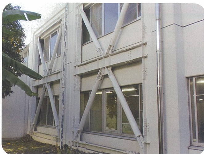
写真2（訓練棟の鉄骨ブレース）
