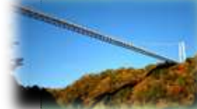
竜神大吊り橋
