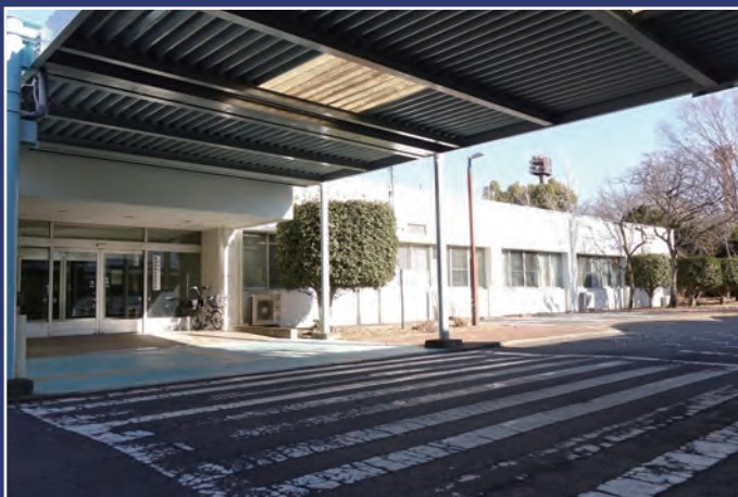
補装具製作棟入口
