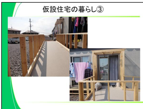
図 27 仮設住宅の裏の部屋の入口につけたスロープ
