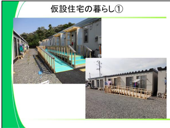
図 25 仮設住宅の玄関に後からつけたスロープ
