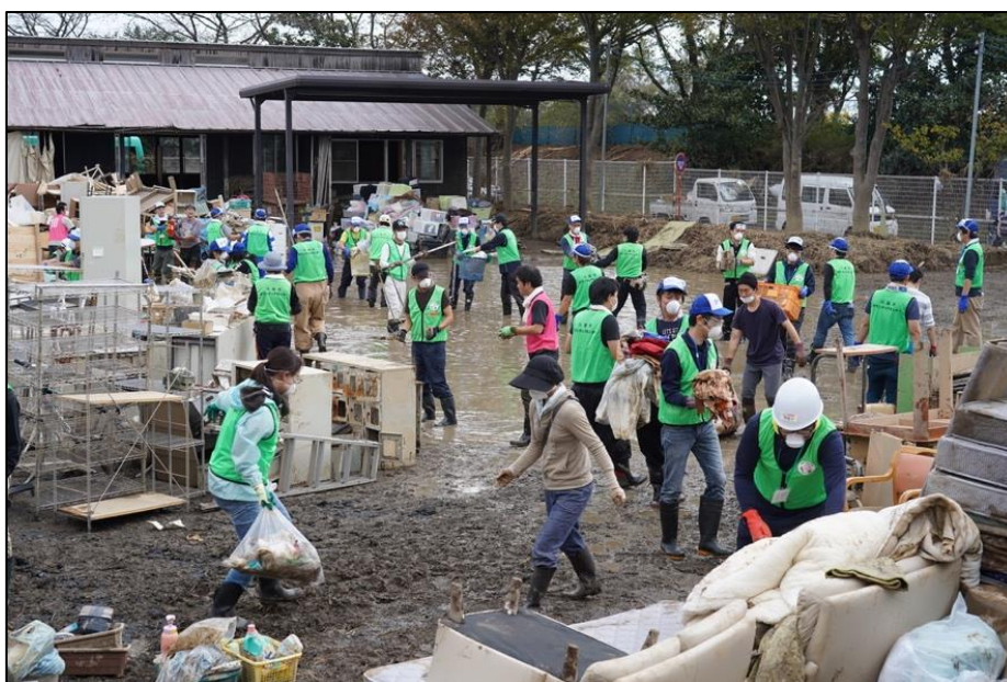
図 16 初雁の家の駐車場に水に浸かった家財を出す災害ボランティア
