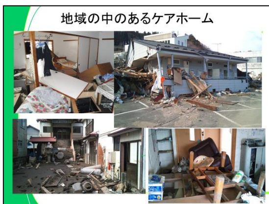
図 12 法人の建物被害：グループホーム
